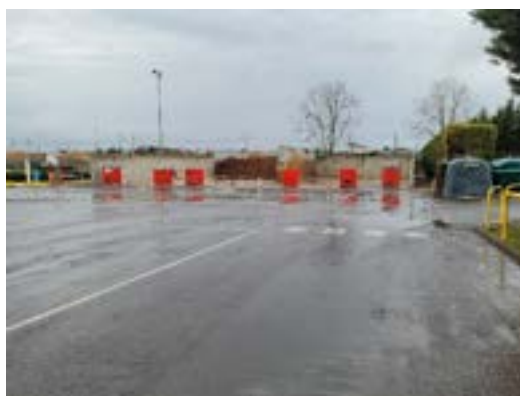
Site destiné à accueillir l'abri OMR / DRATS
